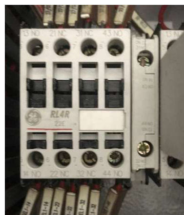
Contatora GE Tripolar RL - 4R
