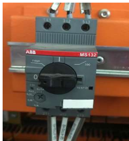
Disjuntor ABB Trifásico MS 132 0,25A
