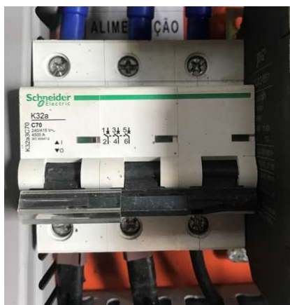
Disjuntor Schneider K 32A Trifásico
