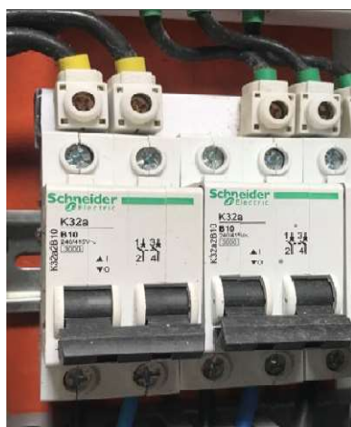
Disjuntor Schneider K 32A Bifásico
