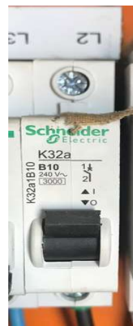
Disjuntor Schneider K 32A Monofásico
