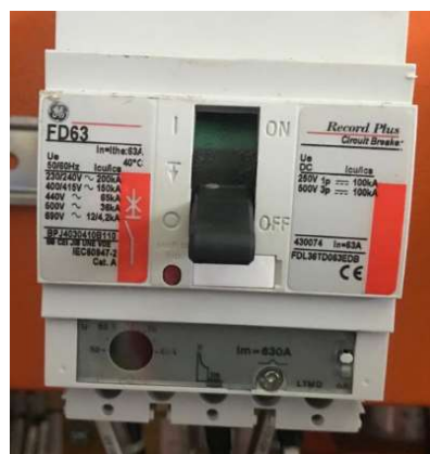
Disjuntor GE Record Plus Fd63 Trifásico 63 A
