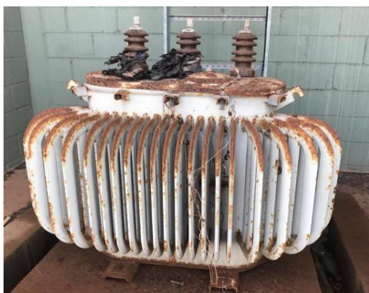
Transformador à óleo Trifásico 112,5KVA Zilmer
