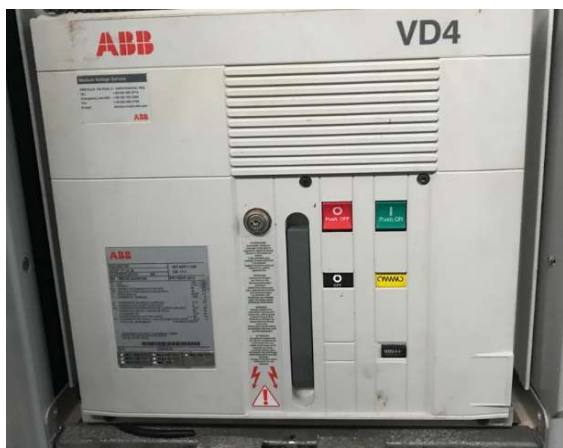
Disjuntor ABB VD4 17,5 Kv Trifásico
