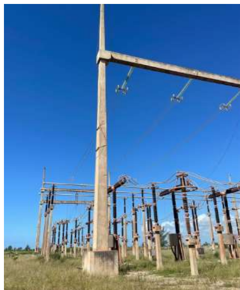
Pórtico de concreto
