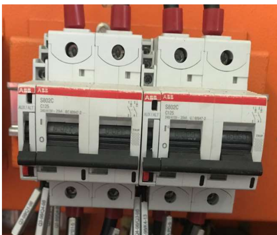
Disjuntor ABB 5802C Bifásico 25 A
