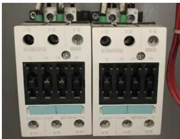
Contatora Siemens Tripolar DILM 15-10
