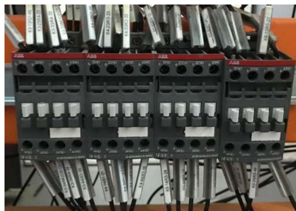
Contatora ABB NF40E
