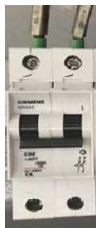
Disjuntor Siemens Bifásico
