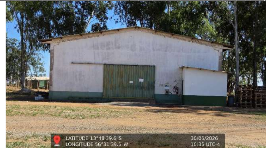
Figura 148 - Imagem do depósito da usina
