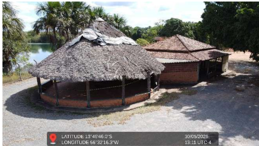
Figura 27 - Imagem do refeitório e área de lazer da sede retiro
