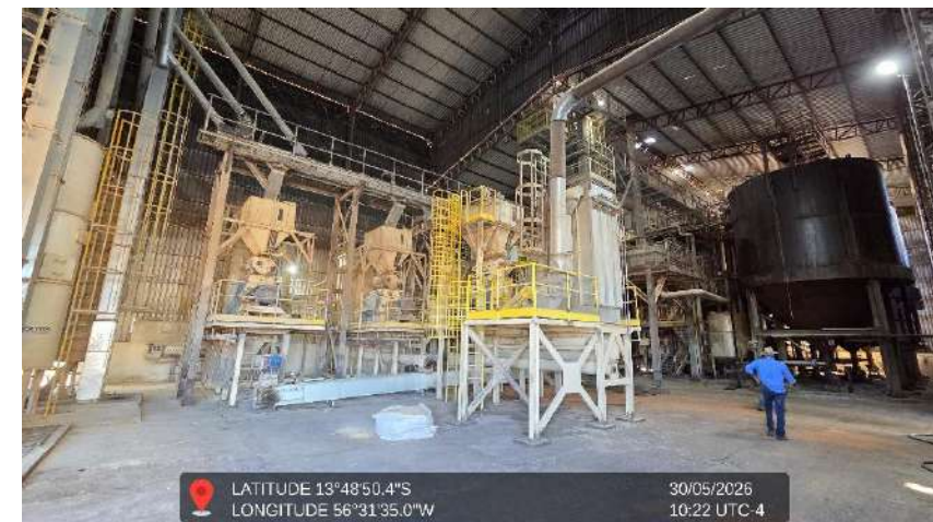
Figura 163 - Imagem do interior da usina
