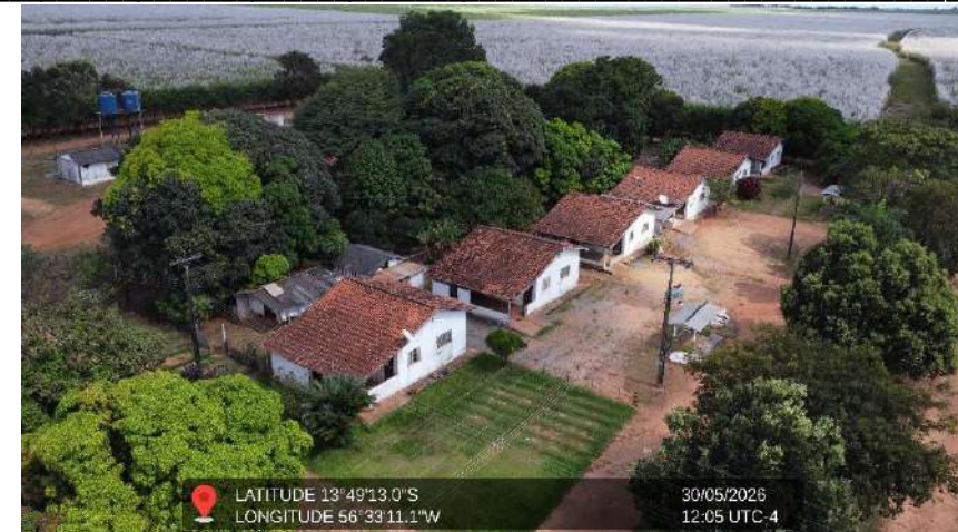
Figura 51 - Imagem aérea das casas de moradia
