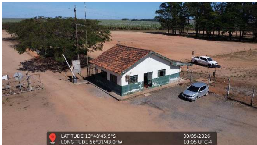
Figura 147 - Imagem da portaria da usina
