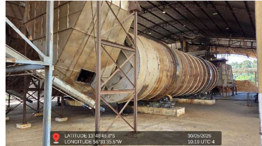
Figura 166 - Imagem das caldeiras em manutenção
