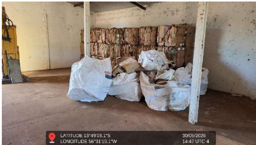
Figura 31 - Imagem da estrutura de reciclagem
