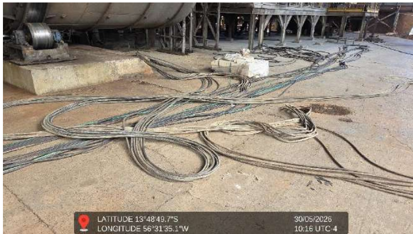
Figura 165 - Imagem dos cabos elétricos em revisão
