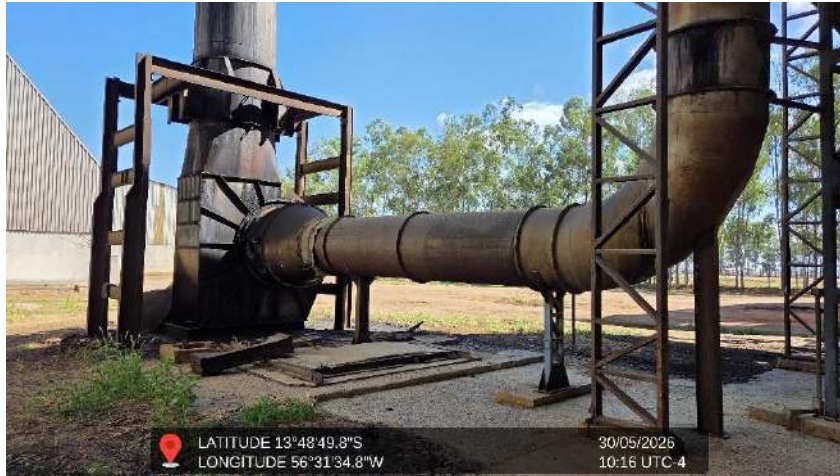
Figura 168 - Imagem da estrutura da caldeira em manutenção
