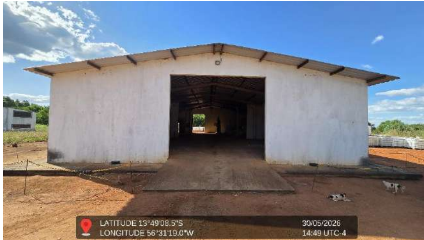
Figura 30 - Imagem da estrutura de reciclagem
