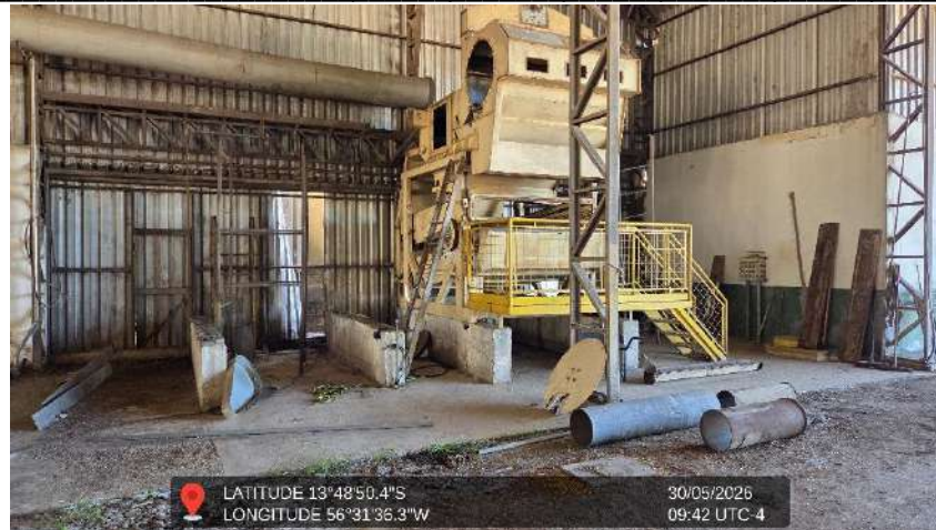
Figura 160 - Imagem do moinho em manutenção do armazém
