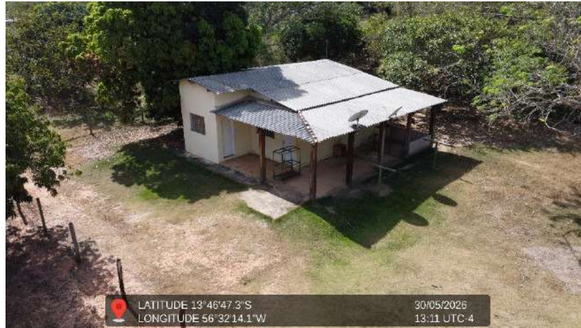
Figura 26 - Imagem da casa da sede retiro
