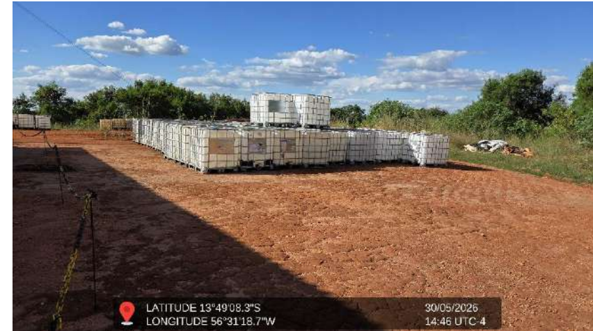
Figura 32 - Imagem da estrutura de reciclagem
